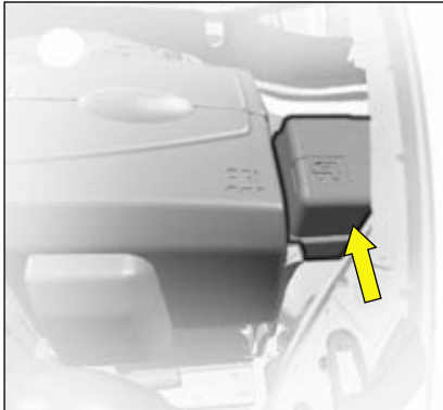
Fusibles sous capot moteur
