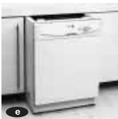
**f** Introduisez le lave-vaisselle dans la niche. Ajustez-le au plan de travail jusqu'à ce que la partie supérieure de l'appareil touche le plan inférieur du plan de travail du meuble de cuisine.
