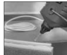
Lepení telef. kabelů.
