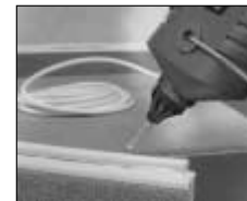
Colocar cabos de telefone.
