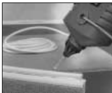
Telefonkábel fektetése.
