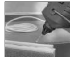
Telefona kabeļu izvietojšanai.
