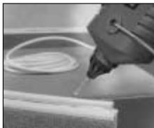
Colocar cables de teléfono.
